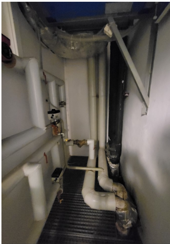
Obok na zdjęciu lokalizacja pionu CT i wody lodowej w szachcie technicznym na IV piętrze.
